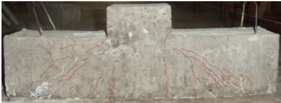
ภาพที่ 6 การวิบัติของคาน B ภายใต้แรงเฉือน
