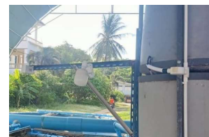
(ค) การติดตั้งอุปกรณ์ควบคุม
