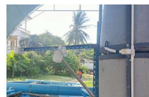
(ค) การติดตั้งอุปกรณ์ควบคุม
